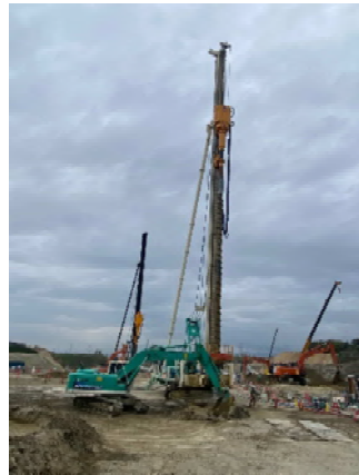
深層混合処理排泥
