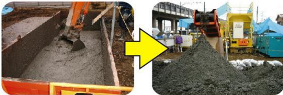
▼泥土圧シールド工法排泥
