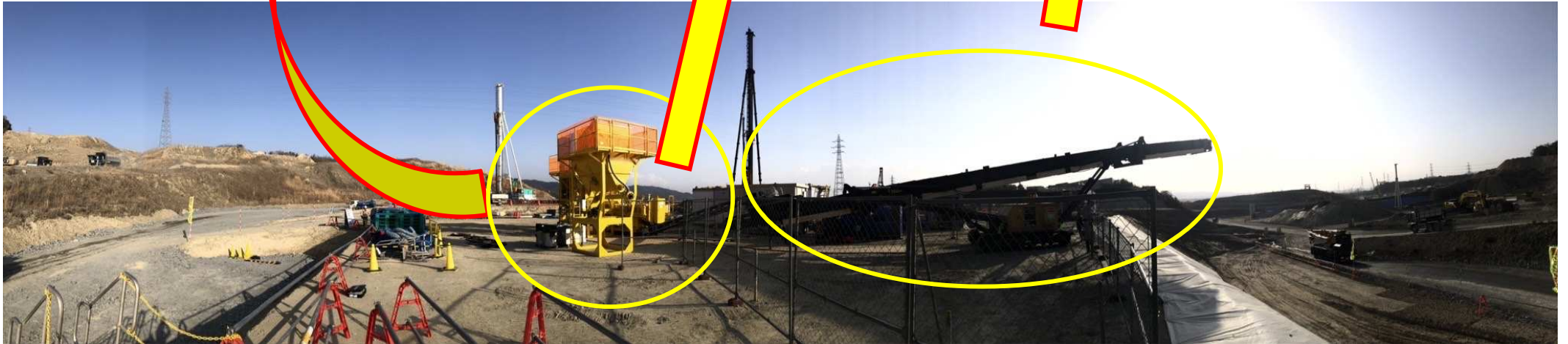
深層混合処理工排泥処理(100m 3 機)
