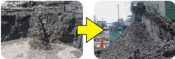
▼泥土圧シールド工法排泥
