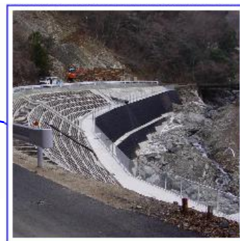
H18 護岸導流堤事例 にがこべ谷川導流堤 (L=115m)
