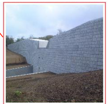
H16 日本最古SBウォール堰堤 三宅島しらみ沢遊砂池堰堤
