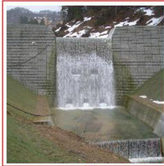
H18 地震災害急速施工例 油夫川砂防堰堤
