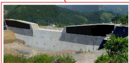
H16 緩衝工事例 集川1号砂防堰堤
